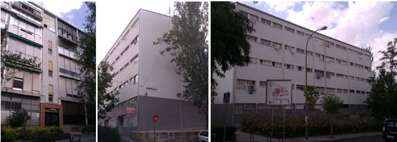
Figuras 25, 26 y 27: Alzados principal, lateral y posterior del único bloque de viviendas al que se ha añadido aislamiento exterior.
